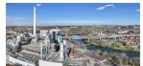
독일 EnBW 수력발전소 : 독일 수력발전시설의 안전 관리 및 환경 보호 방안 시찰
